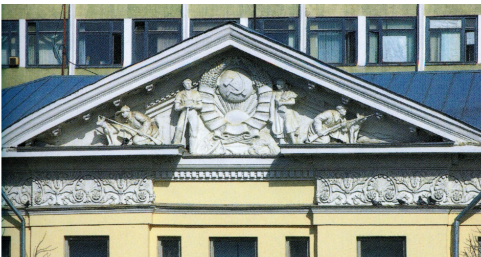
Ил. 407. Камбаров И.А. Рельеф на фронте здания Управления НКВД. 1930-е. Свердловск.
