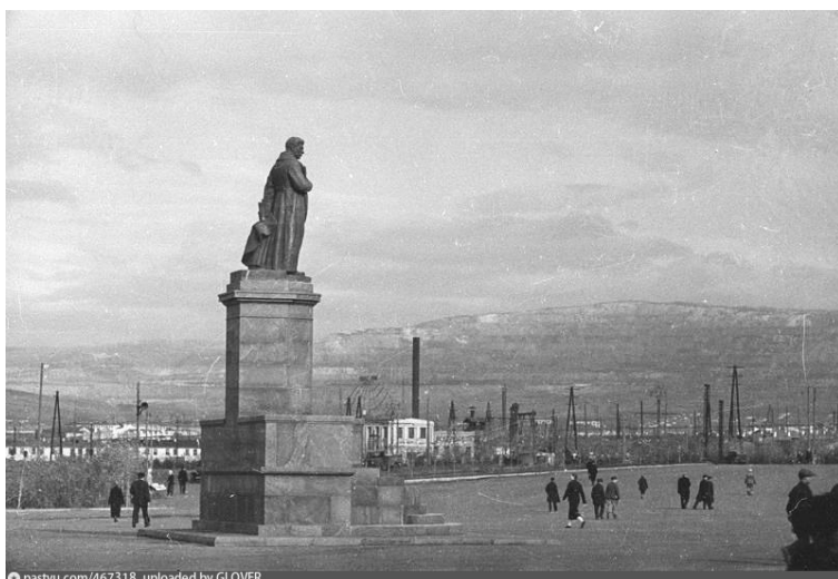
Ил. 405. Памятник Сталину. Скульптор С. Меркуров, архитектор Б. Данчич. 1938. Площадь Заводоуправления Магнитогорск.
